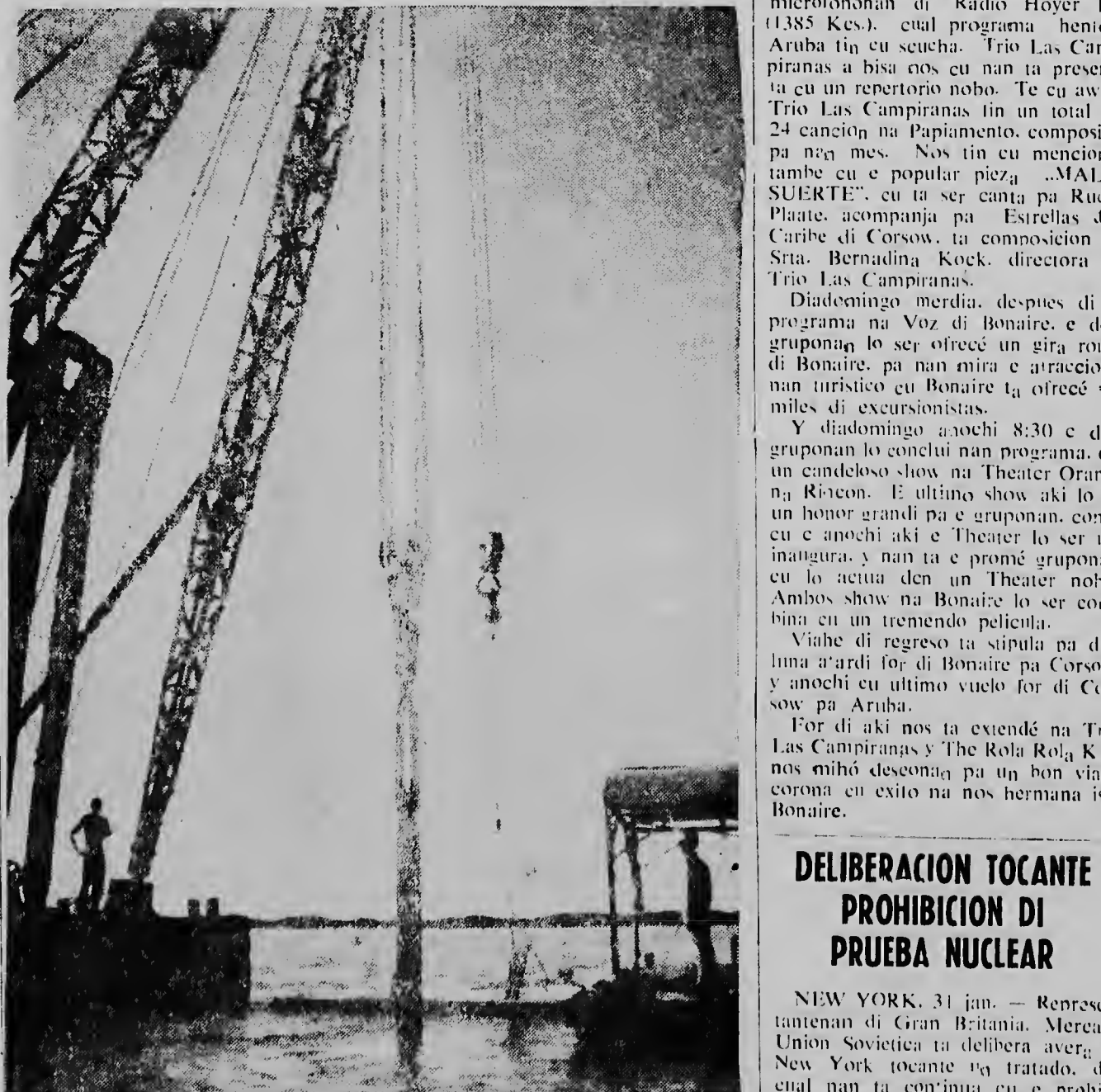
E grua riba awa a caba di baha un blokki di 50 ton. E duiker ta traha baha di awa awor pa pone e blokki na su lugar. Na robz ta para e hember cu tin contacto cu e duiker pa medio di un cabuja.
